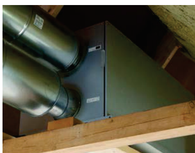
HCH típus padlástérbe szerelve
