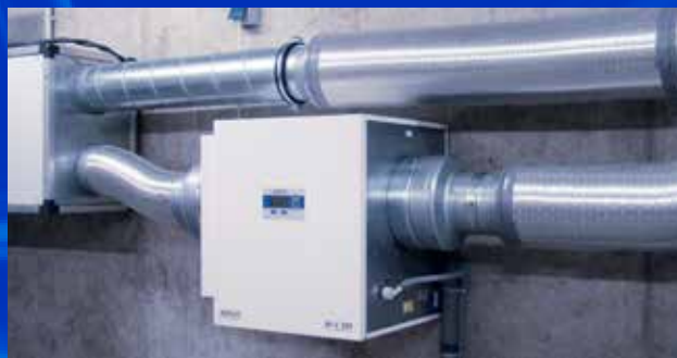
MERLIN® Air-C 500, légcsatorna rendszerbe építve
