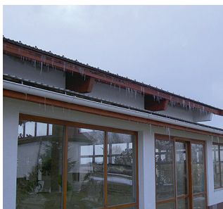
Tervezési és kivitelezési hibák sokasága: az épület szerkezete nem szigetelt, nem zárt, a kiömlő párából keletkeznek a jégcsapok
