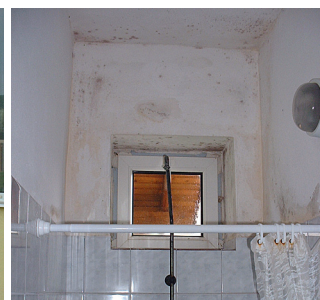
A szellőztetés és a páratlanítás lehetőségének teljes hiánya miatt elpenészedett uszodateri zuhanyfülké
